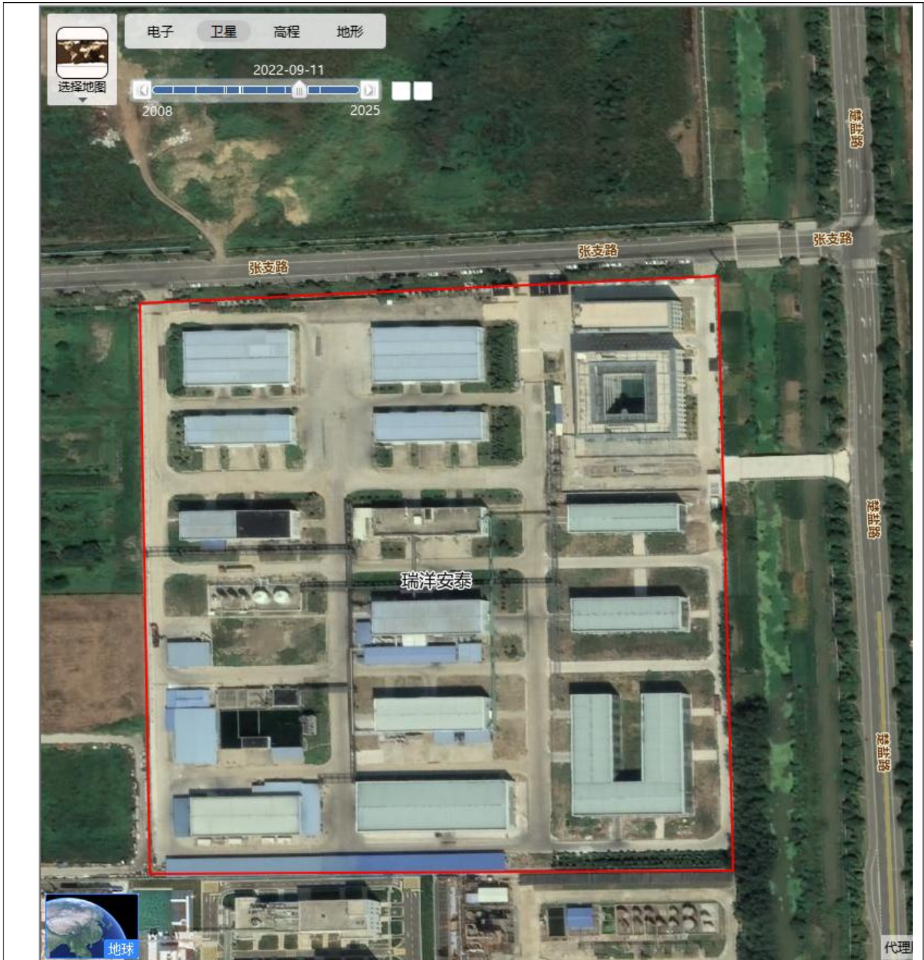
2022年9月11日卫星影像图，图片显示地块内江苏瑞洋安泰新材料科技有限公司二期基本建成，与2020年相比有明显变化。
