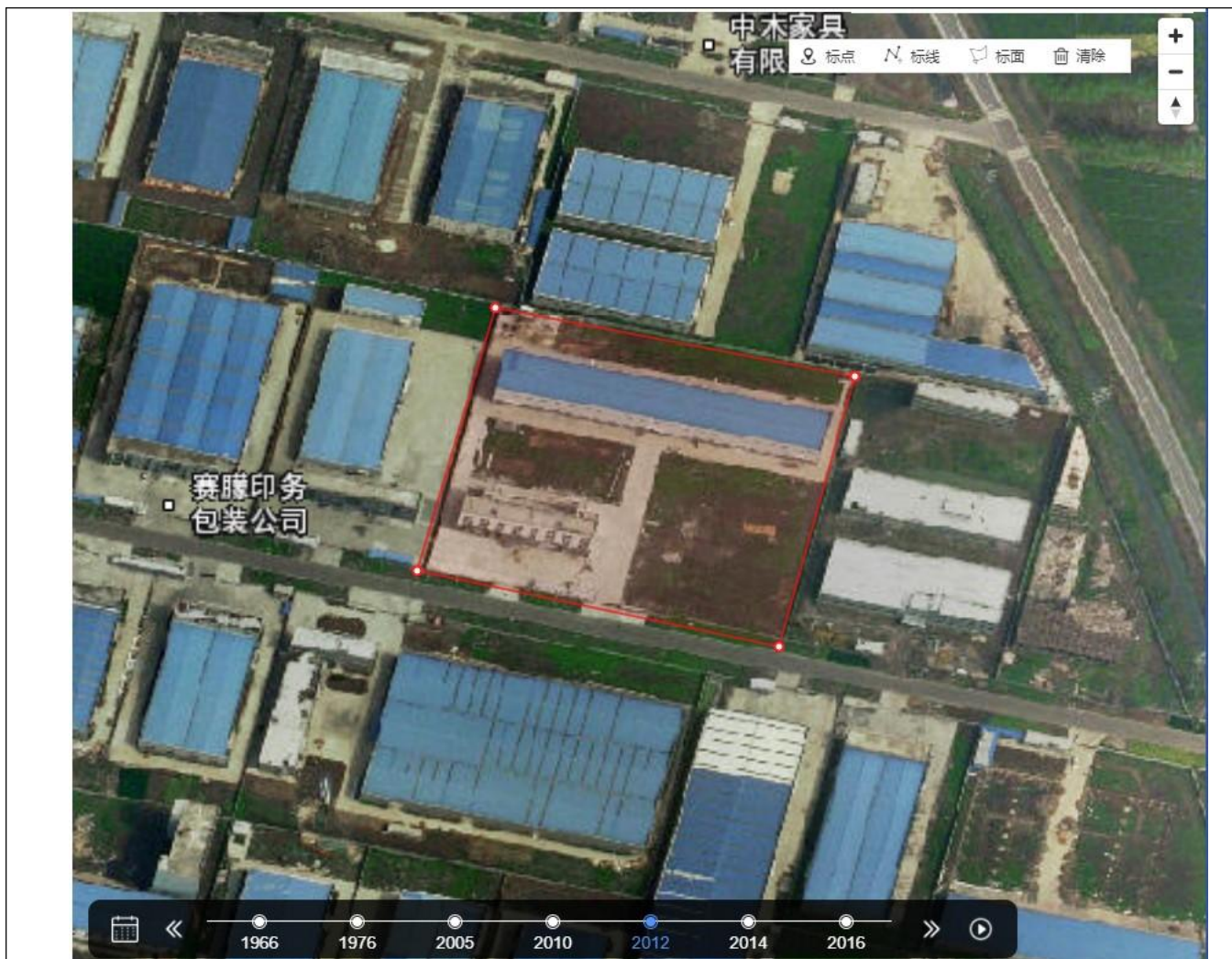
2012年天地图历史影像图，图片显示地块内地块内江苏南方建设有限公司基本建设完成，与2010年相比有明显变化。
